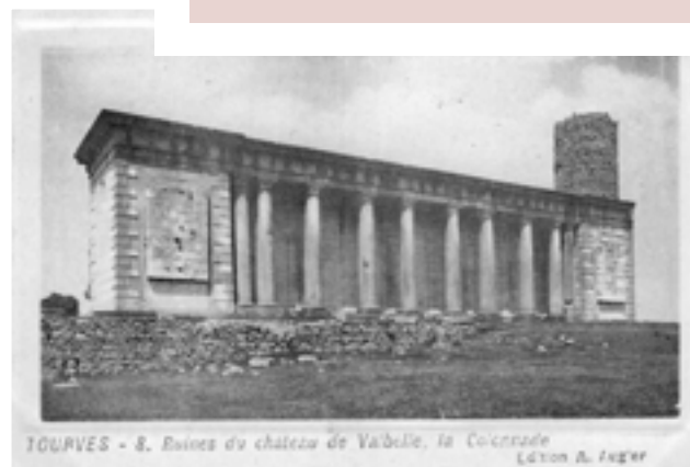
Cote 2 FI TOURVES 31, Les ruines de Valbelle, Conseil départemental 83, Archives Départementales, Tous droits réservés
