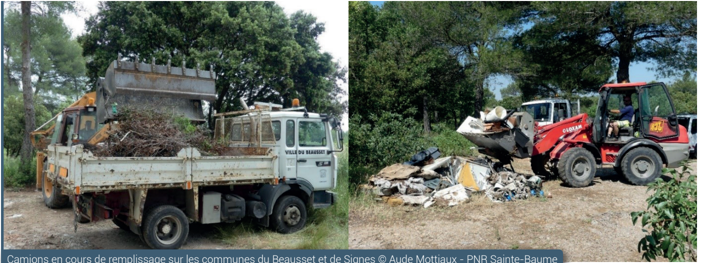
Camions en cours de remplissage sur les communes du Beausset et de Signes © Aude Mottiaux - PNR Sainte-Baume
