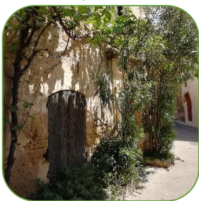
Redonner de la place au végétal en centre ancien
